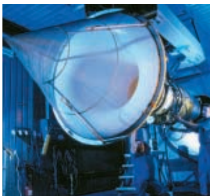
Mantenimiento de un motor
